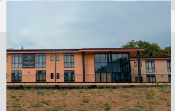
En 2011 se inauguró la Residencia San Vitorio (Baralla, Lugo) en un entorno con una gran demanda de plazas.
